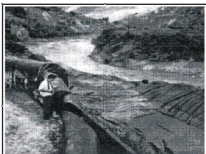
En la vista el oleoducto a orillas del río Marañón, después de haber sido destruido por un huaico que cayó en época de lluvias intensas.
